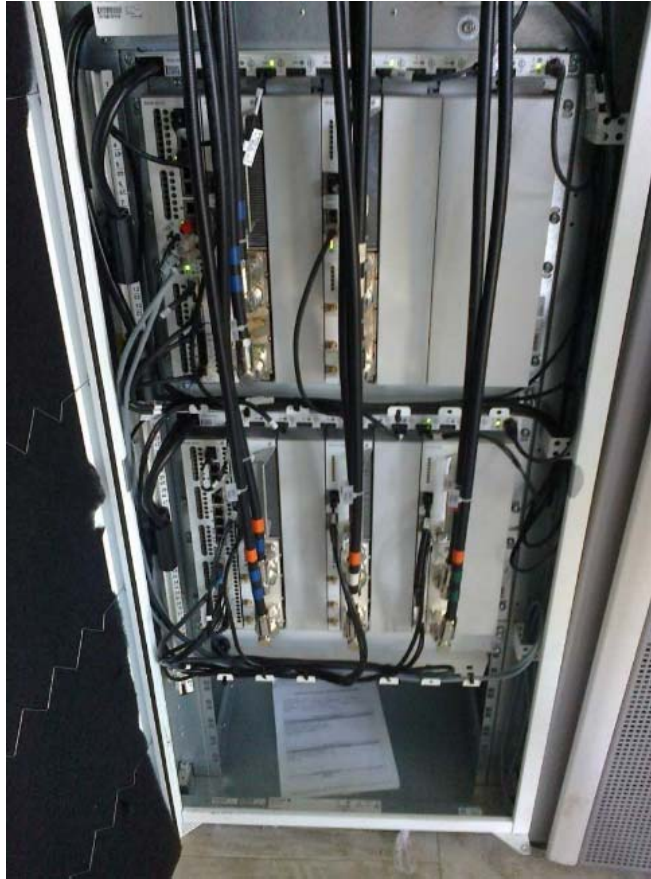
Figura. Copia de Check List de la Instalación Tarjetas en RBS 6201.
